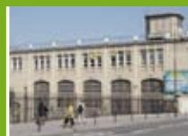
Centrale sous-station électrique (Ch Genuys, 1912)
