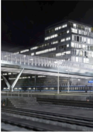
Vue de nuit au niveau des quais
